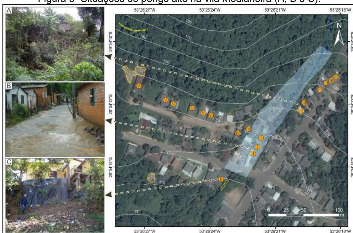
Figura 6- Situações de perigo alto na vila Medianeira (A, B e C).
